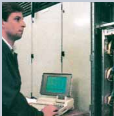
Inbetriebnahme – der Countdown läuft
